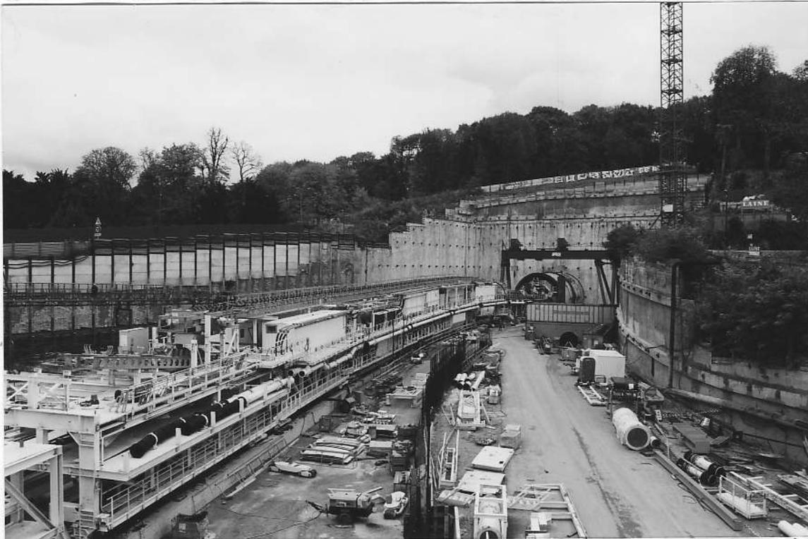
Commencé en juillet 2000, assemblage des éléments du tunnelier qui forera les 10 kms du tunnel Est passant sous le Bois de St Cucufa.
